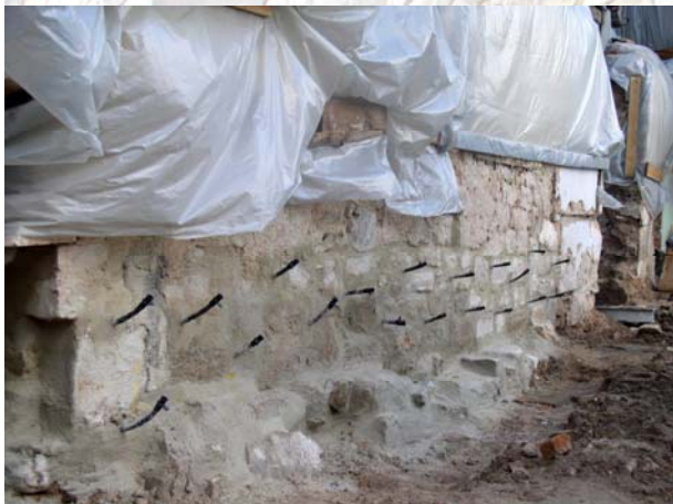
Fundamentinjektion zur statischen Sicherung
