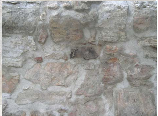
Mauerwerk maschinell verfugen und anschließend sandstrahlen -Sichtmauerwerk
