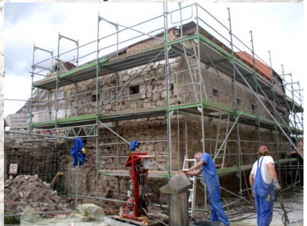
Einbau von Edelstahlnadeln in das zweischalige Mauerwerk mit anschließender Mauerwerksinjektion
