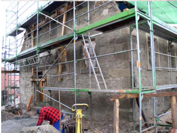
Reinigen des Mauerwerks, anschließende maschinelle Verfugung als Putzträger
